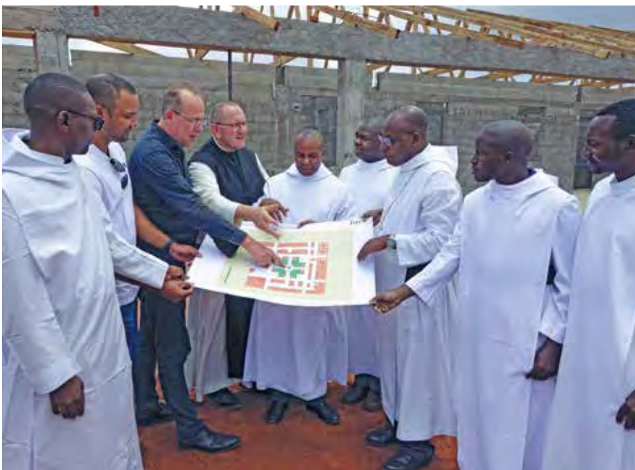
Besprechung der Baupläne fürs neue Kloster in Mecua in Mosambik. Es geht voran!
